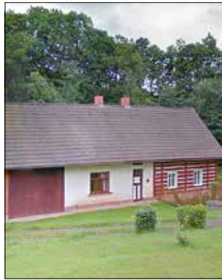
ehem. Geburtshaus in Stupna
