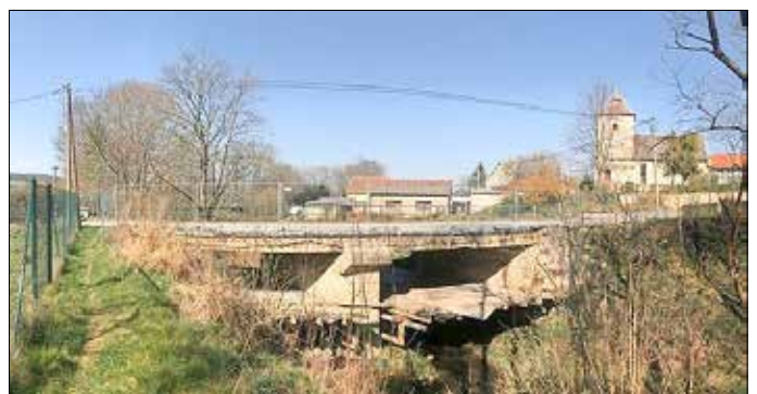
Die Straßenbrücke am Gutshaus in Großgestewitz wird umfangreich saniert.
