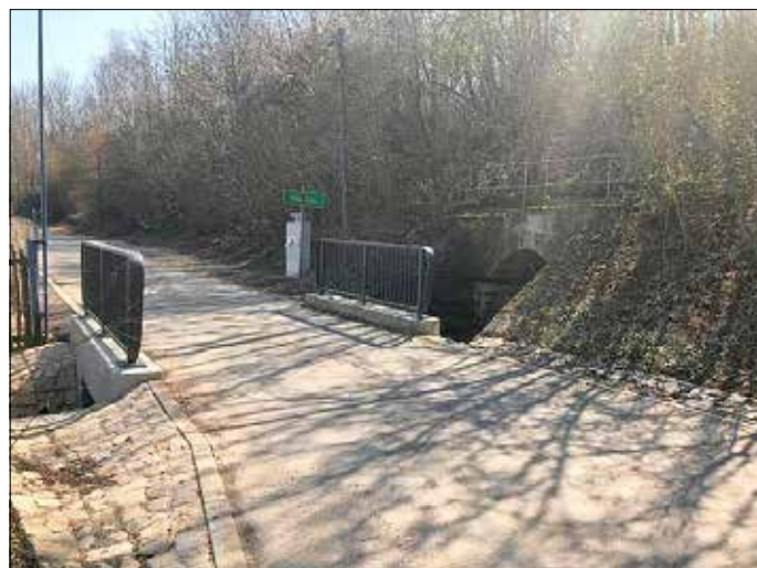
Das erneuerte Durchlassbauwerk verbindet die Schönburger „Splittersiedlung“ Weichau mit der Kreisstadt Naumburg.
