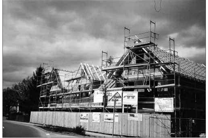
Der Rohbau steht.
