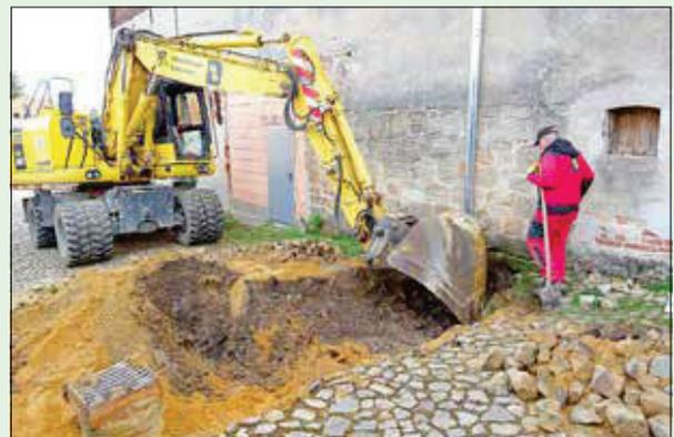
In der Schlippe ist die Naumburger Bauunion zu Gange. Rohre zur Einleitung der Dachentwässerung in den Regenwasserkanal werden verlegt, Gehwege in Betonsteinpflaster auf einer Breite von 3,65 bis 4,90 Meter Breite entstehen und die Straße erhält auf rund 80 Metern Länge einen Asphaltbelag.
