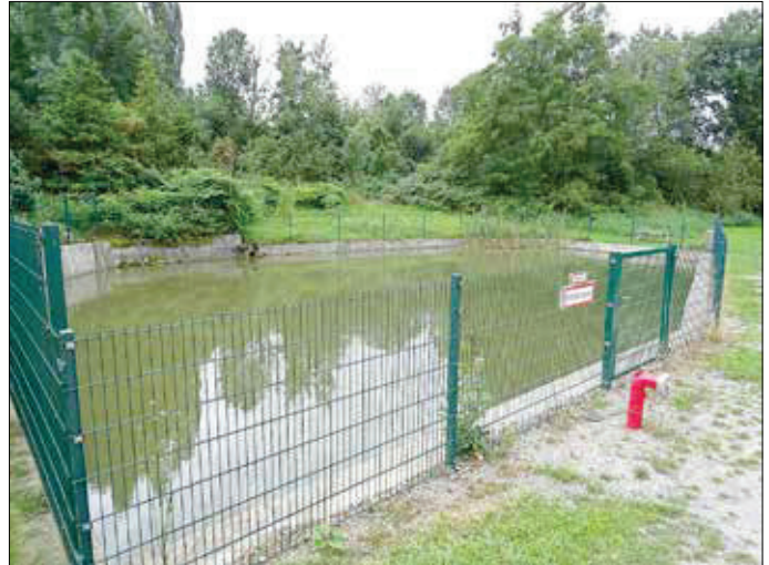
Naturteich in Droitzien, im Rahmen der Dorfsanierung zum Feuerlöschteich hergerichtet.
