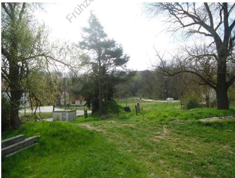
Bereich der Zufahrt zum Grundstück mit Blick auf die Trafostation
