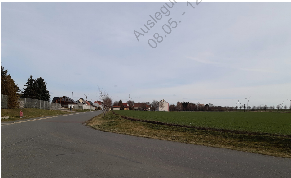
Abb. Blick von der Zufahrt zur Feuerwehr
